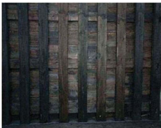
繁柱板倉の構造
