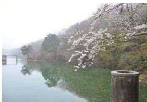
加瀬沼と取水塔
