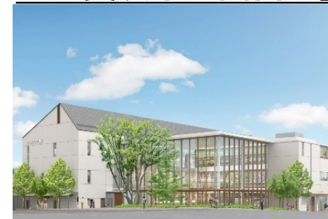
「多賀城市立図書館」
