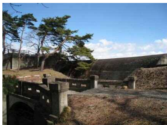
加瀬沼堰堤と加瀬沼橋
