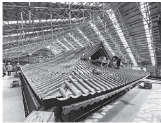
瓦葺き工事の様子
