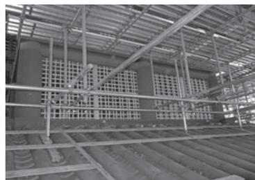
二重の柱と柱の間に、木舞と呼ばれる下地材が施されたところ。
