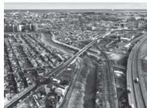
緊急避難路・物流路 (清水沢多賀城線)整備事業
