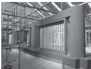
二重柱の組立状況
