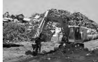
がれき等の処理（中間処理施設）
