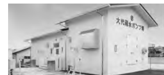
雨水排水機能の強化・大代雨水ポンプ場
