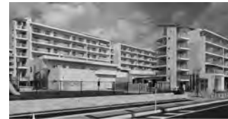
桜木災害公営住宅（現市営桜木住宅）
