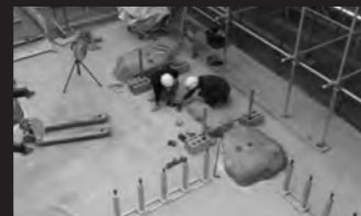
2020年8月 礎石据え付け
