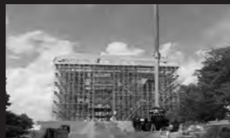
2020年8月 素屋根工事
