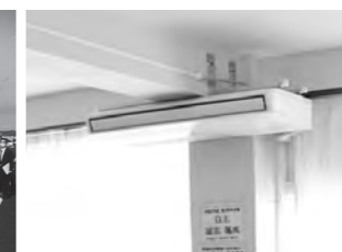
学校環境整備事業 写真は「エアコン設置」
