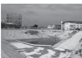
平成30年9月撮影 八幡第一雨水調整池整備事業
