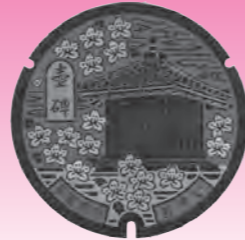
汚水マンホール
