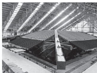
写真中央に見える太い材が隅木、丸く加工されて並んでいる材が地垂木です。
