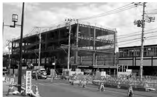
建設工事中の再開発ビルB棟(平成27年10月6日撮影)
