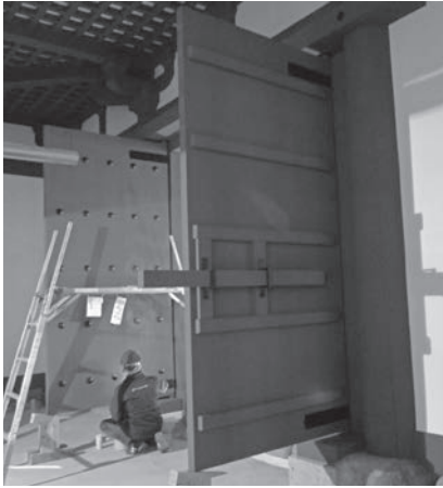
扉の取付工事の様子です。扉の前で塗装作業を行っている職人と比較すると、その大きさが見て取れます。
