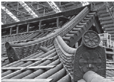
写真右下/隅棟の先端に設置された鬼瓦
