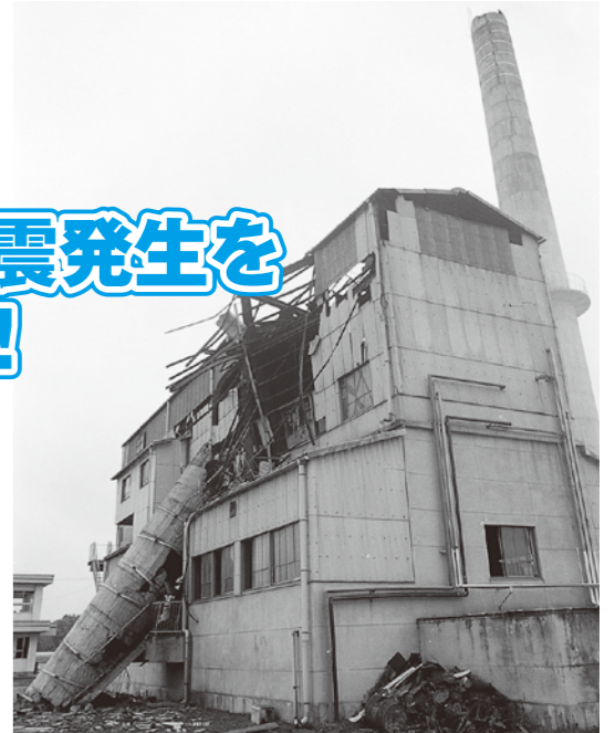
写真：昭和53年6月12日に発生した「宮城県沖地震」による市内の被害の様子。
