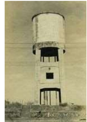
右：旭ヶ岡高架水槽
