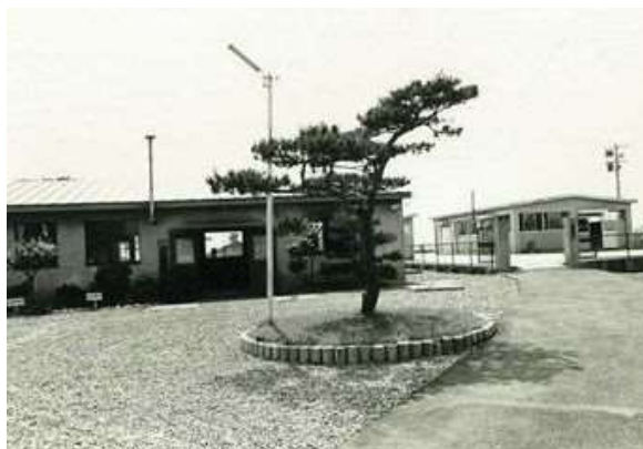
左：末の松山配水場(昭和47年)
