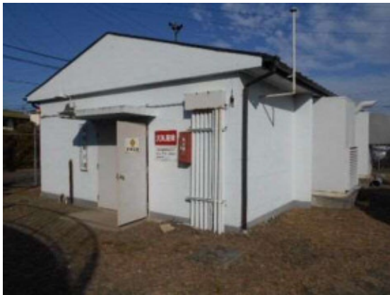
岡田集水場電気棟
