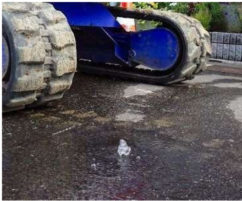
地表に現れた漏水の様子
