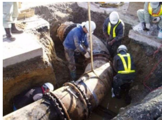
東日本大震災での漏水事故の修繕状況 (市川地区多賀城碑前)
