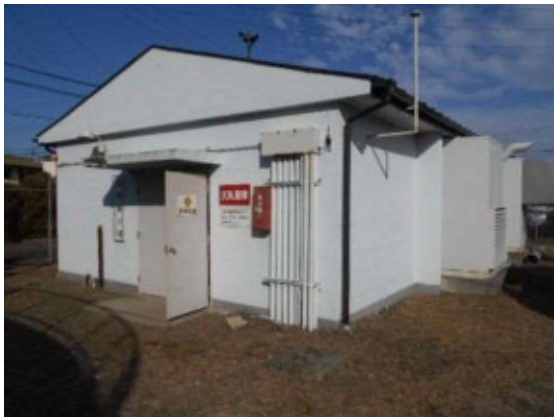
岡田集水場電気棟
