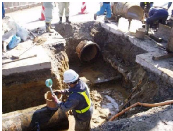
多賀城市管工事業協同組合による漏水修繕の状況 多賀城市市川地区（多賀城碑前）
