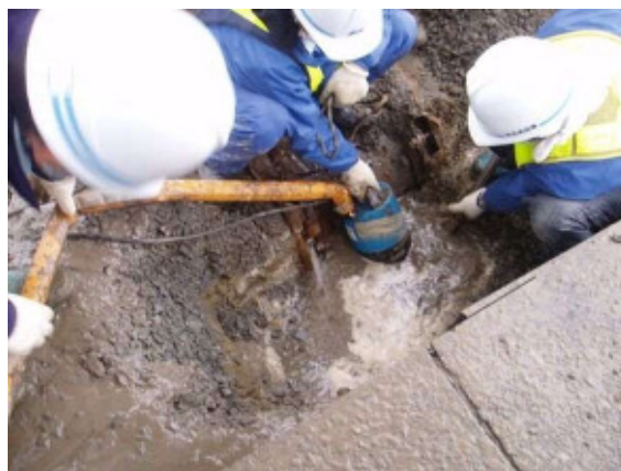
多賀城市管工事業協同組合による漏水修繕の状況 多賀城市市川地区（多賀城碑前）
