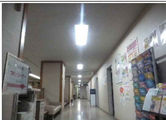
蛍光灯型LED照明器具の導入
