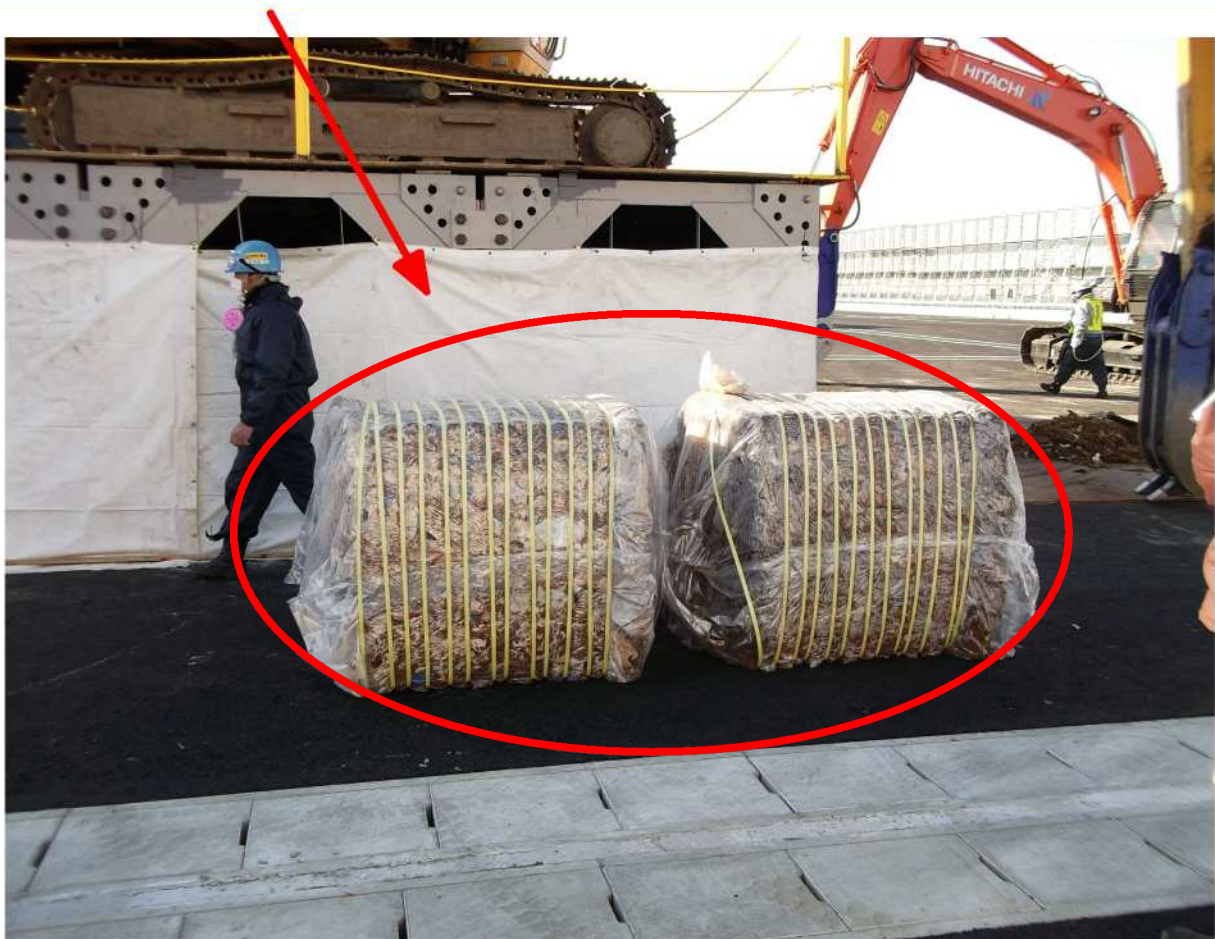
粗大系可燃物の圧縮梱包材の大きさは、概ね1メートルの立方体で重さは平均700kg
