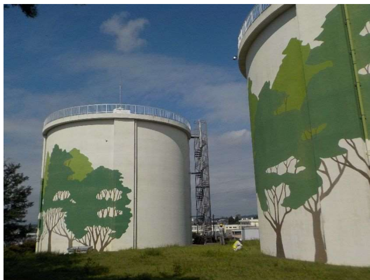
天の山配水池
