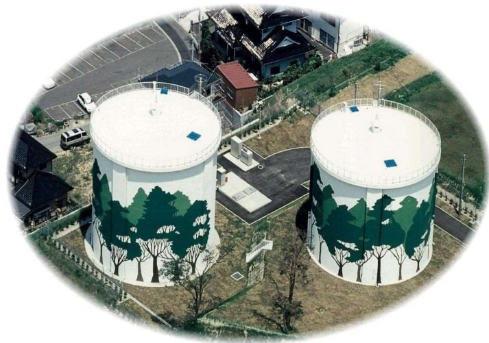
天の山配水池
