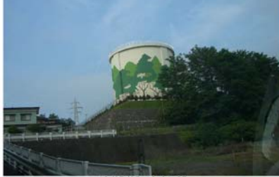
天の山配水池
