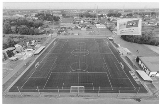
▲2016年(平成28年)5月に完成した境町サッカー場
