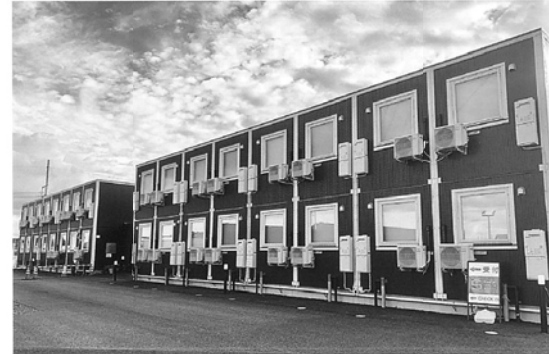
▲2020年(令和2年)3月に完成した移動式木造住宅（ムービングハウス）
