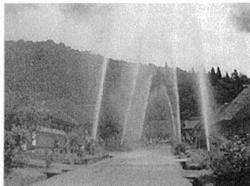
放水銃 28 基の一斉放水（9/1 防災訓練）
