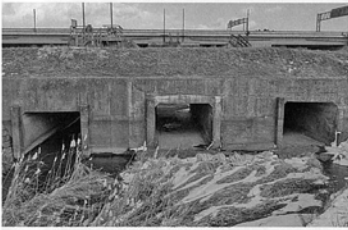
動かない3機の樋門
