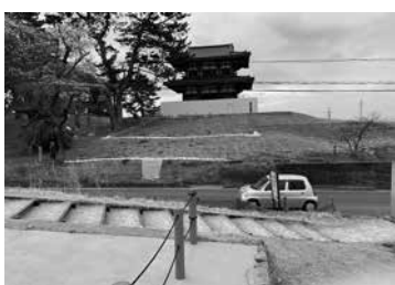
▲建設が進む南門の北側付近
