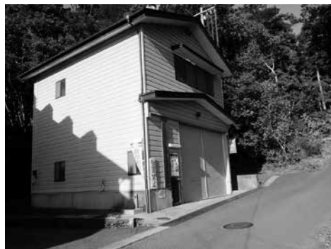
▲現在の第4分団ポンプ車置き場施設写真
