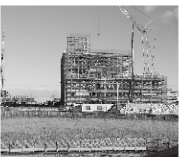
▲蒲生地区に建設中の発電所
