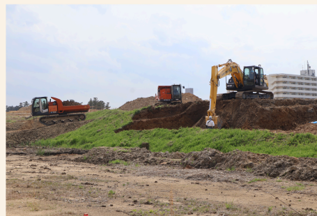
▲①表土掘削の様子
