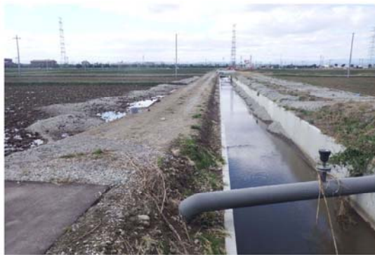
【庚田水路横断した流水後の状況】
