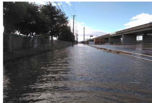
【八幡小学校と三陸縦貫自動車道の間 浸水状況】
