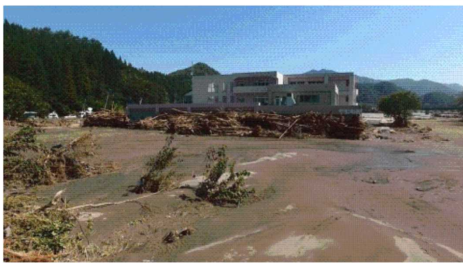
平成28年台風第10号による被害状況
